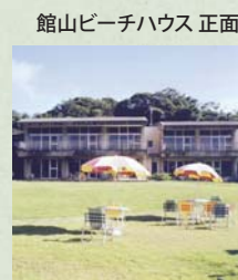
館山ビーチハウス 正面
